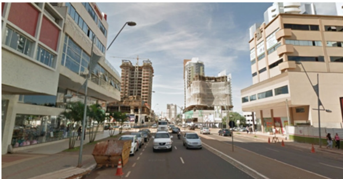
Edital nº009/2007: Contribuição de Melhoria na Av. Horácio Raccanello em Maringá-PR. - 97,99% dos custos da obra foram recuperados.
