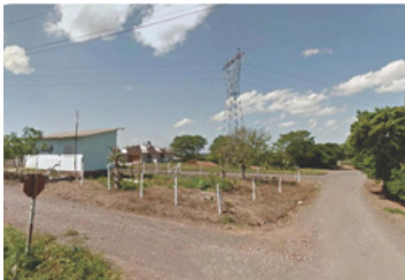
Contribuição de Melhoria na Rua Cel. Brito – Venâncio Aires-RS (ANTES da obra)
