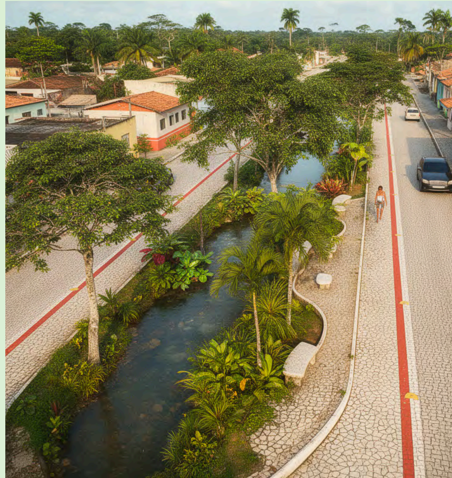
INTERVENÇÃO CANAL NOVA ESPERANÇA
